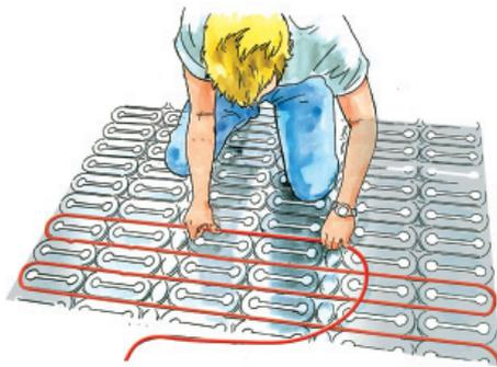
После укладки всего кабеля в пластине прорезается отверстие для установки концевой муфты. Вырежьте часть пластины. Зачистите и закруглите острые углы и края. Затем уложите конец кабеля между двумя кусками алюминиевой фольги, которая должна заходить и на алюминиевое покрытие пластины.
