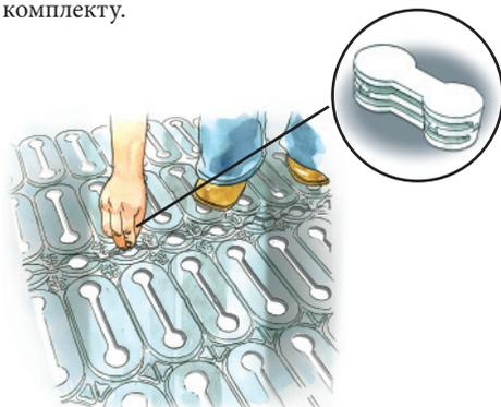
Терморегулятор можно установить в любой части помещения. Так как соединительный конец кабеля и гофротруба датчика температуры пола имеют большую толщину, то в месте их размещения на пластине Devicell™ dry вырежьте часть пластины. Зачистите и закруглите острые углы и края, в особенности в тех местах, где с ними соприкасается кабель.
