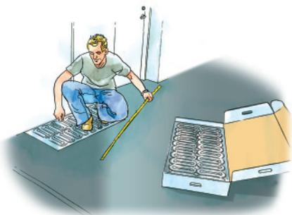
Пластины легко подгоняются под помещение любого размера - их размер можно скорректировать при помощи режущего инструмента- ножовки, электролобзика. Острые края необходимо зачистить и закруглить.
